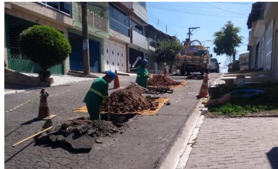
Troca dos ramais de água para a nova rede
