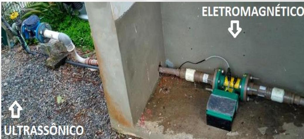
3. Os medidores foram devidamente calibrados antes do início do estudo pelos próprios fornecedores encontrando-se dentro do túnel de erros admissíveis.
