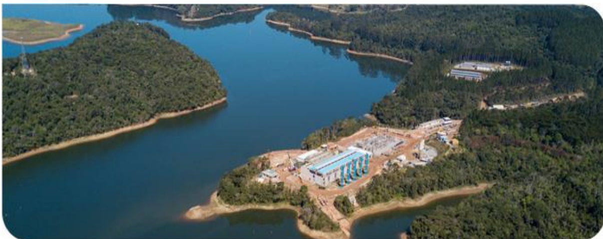
Sistema São Lourenço. Fonte: Sabesp.
