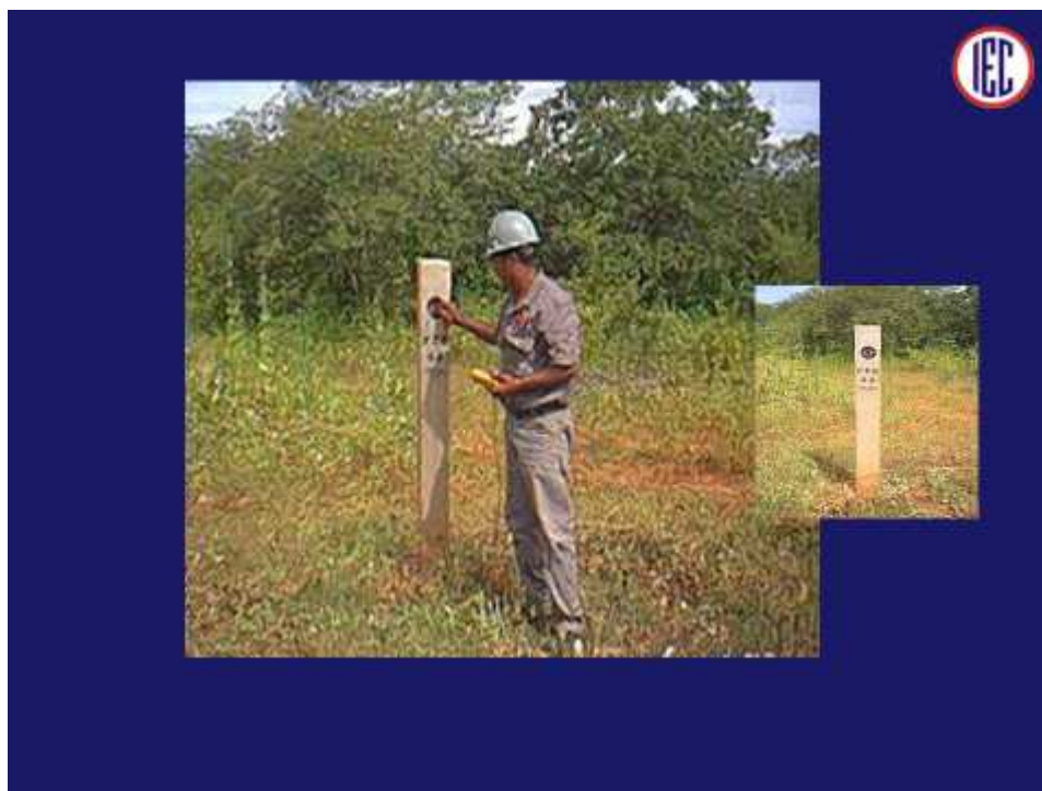
Figura 11: Medição do potencial de proteção catódica no Ponto de Teste de uma adutora enterrada. O Ponto de Teste possui um fio elétrico ligado à adutora.
