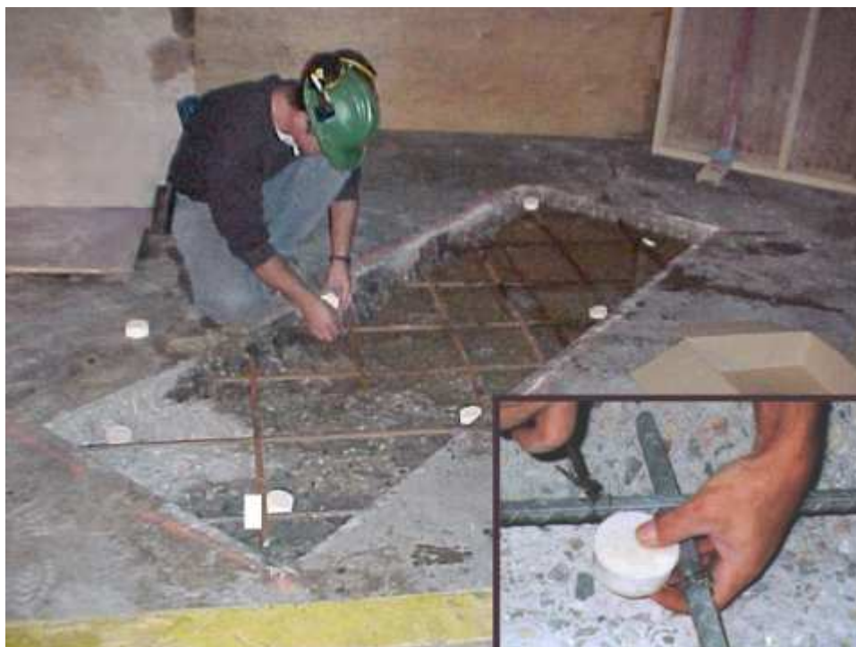
Figura 9: Instalação de anodos de proteção catódica durante os serviços de recuperação do concreto.
