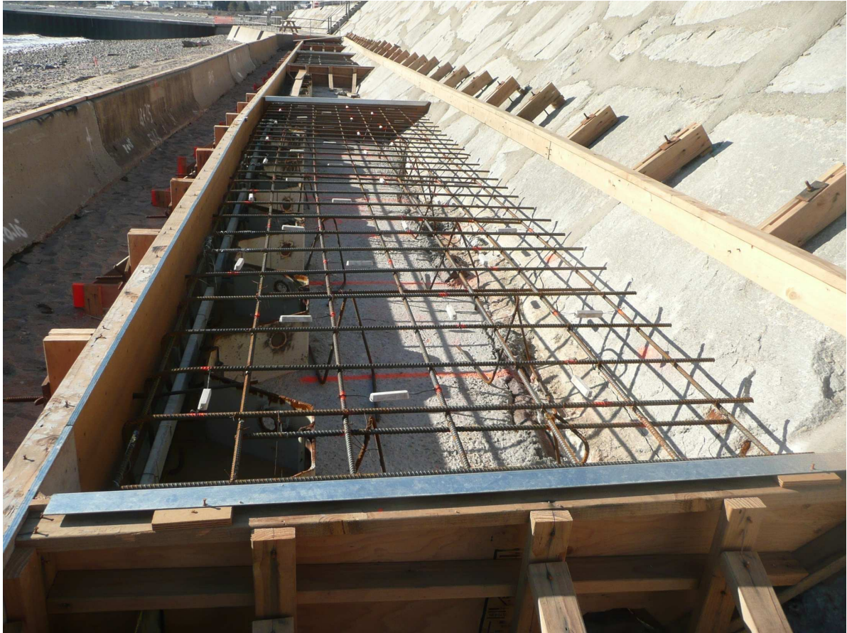
Figura 8: Instalação de anodos de proteção catódica em uma obra de concreto em construção. Os anodos são fixados às ferragens antes da concretagem.
