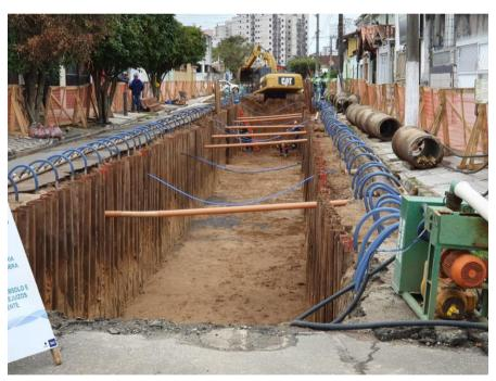
As estacas prancha foram cravadas através do martelo vibratório modelo VPA MV-35T adaptado em escavadeira hidráulica. O tempo médio de cravação foi de 12 peças/hora.
