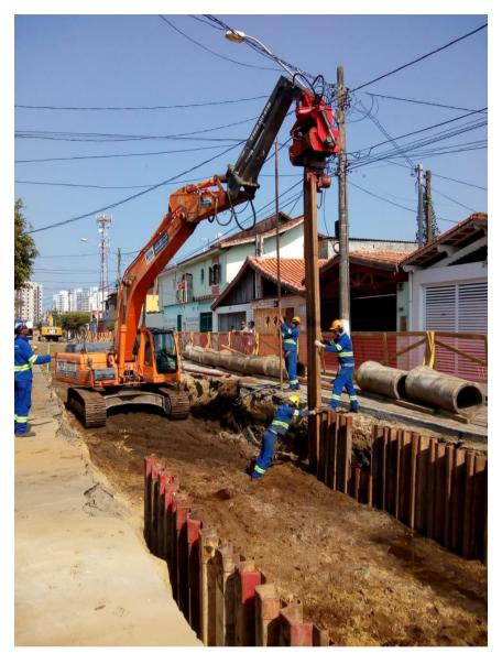
O relatório de sondagem utilizado para elaborar o dimensionamento do escoramento e avaliar a cravabilidade das estacas prancha com o martelo vibratório, apresenta SPT máximo de 20 golpes.
