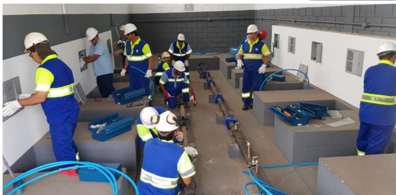
Figura 19: Centro de Treinamento RA – Curso NA20 - SENAI: Conserto de Vazamentos, Instalação de Novas ligações - Parte Prática
