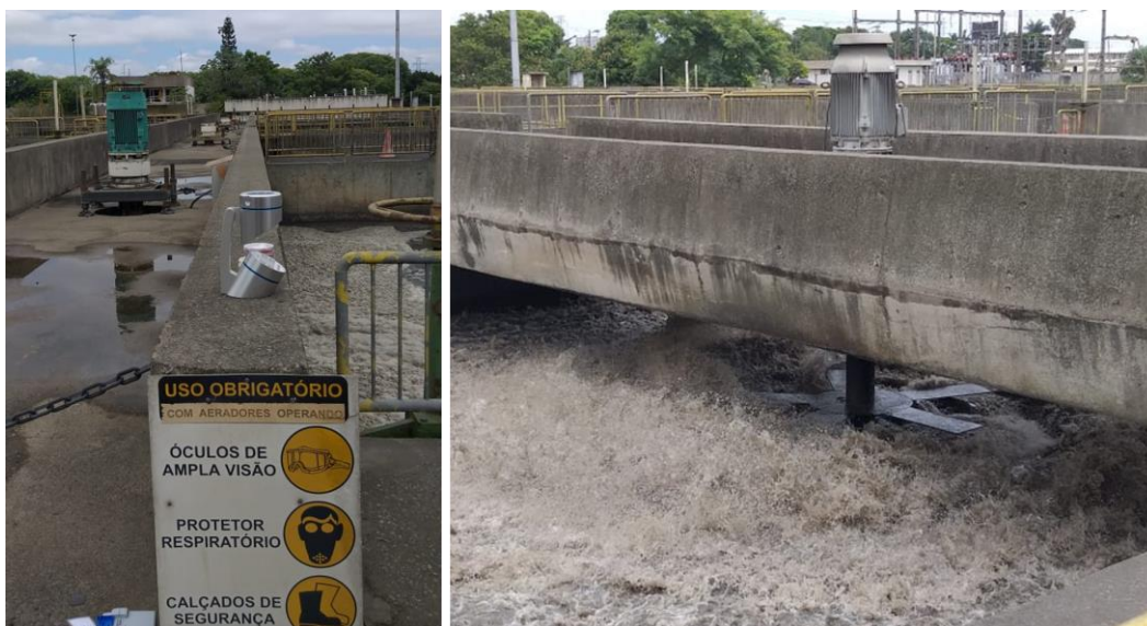
Figura 3: Ponto de coleta 1 e tanque de aeração. Fonte: a autora
