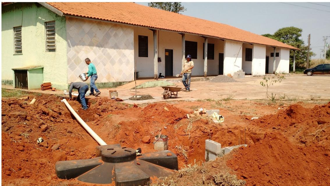
**Figura 1. Instalação da fossa séptica biodigestora em uma das propriedades atendidas.**
