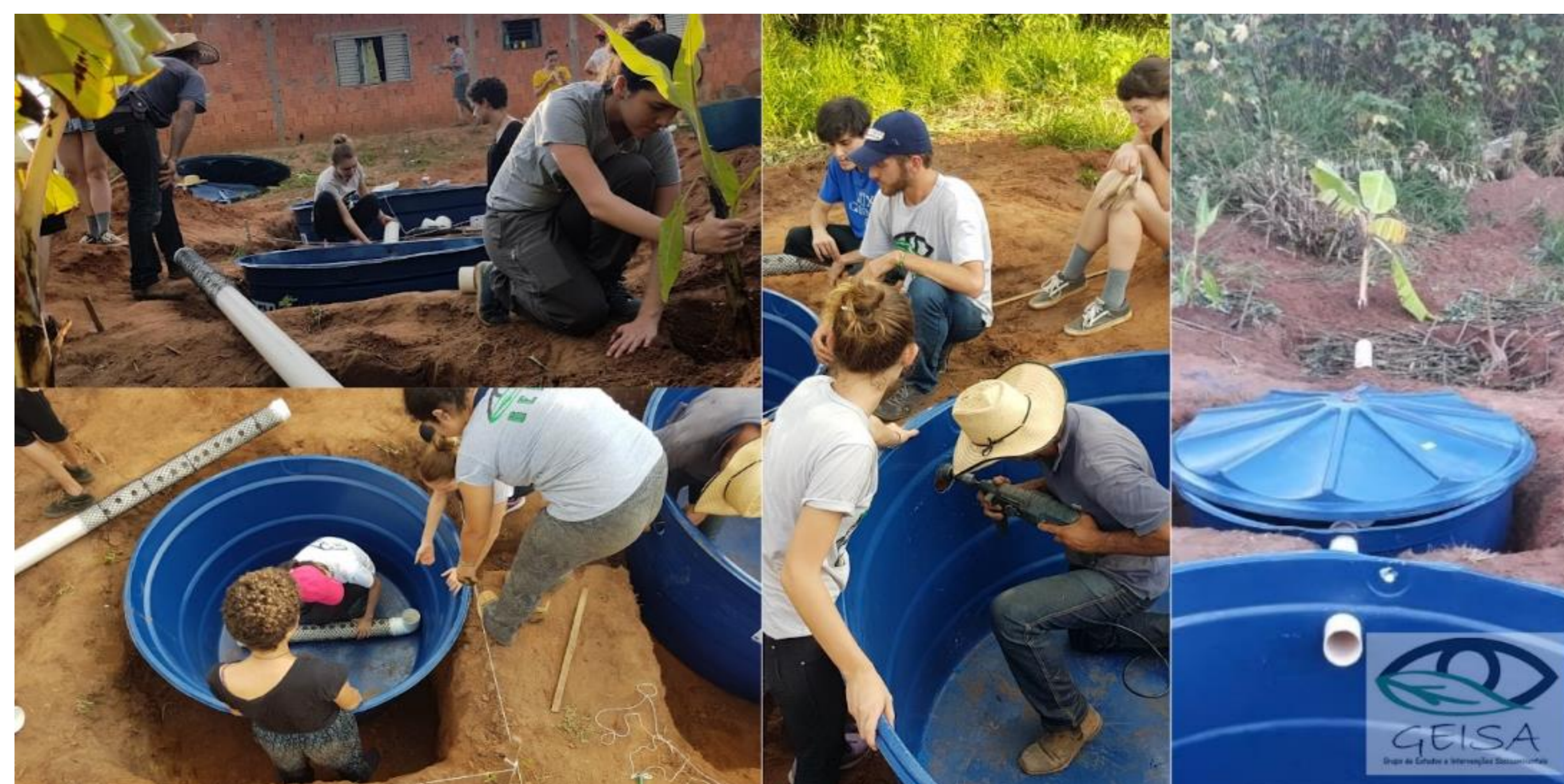
Figura 2 – Oficina para implementação da tecnologia de tratamento de esgoto
