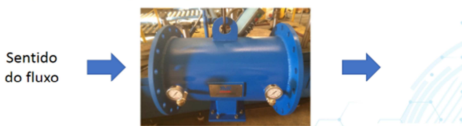
Figura 4: Anteparo de Partículas (Fonte: Colaborador Sabesp - MM Caldeiraria)
