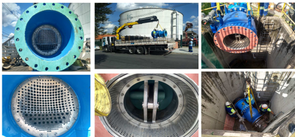
Figura 7: Entrada de água (Fonte: Instalação no reservatório Francisco Morato - Centro)
