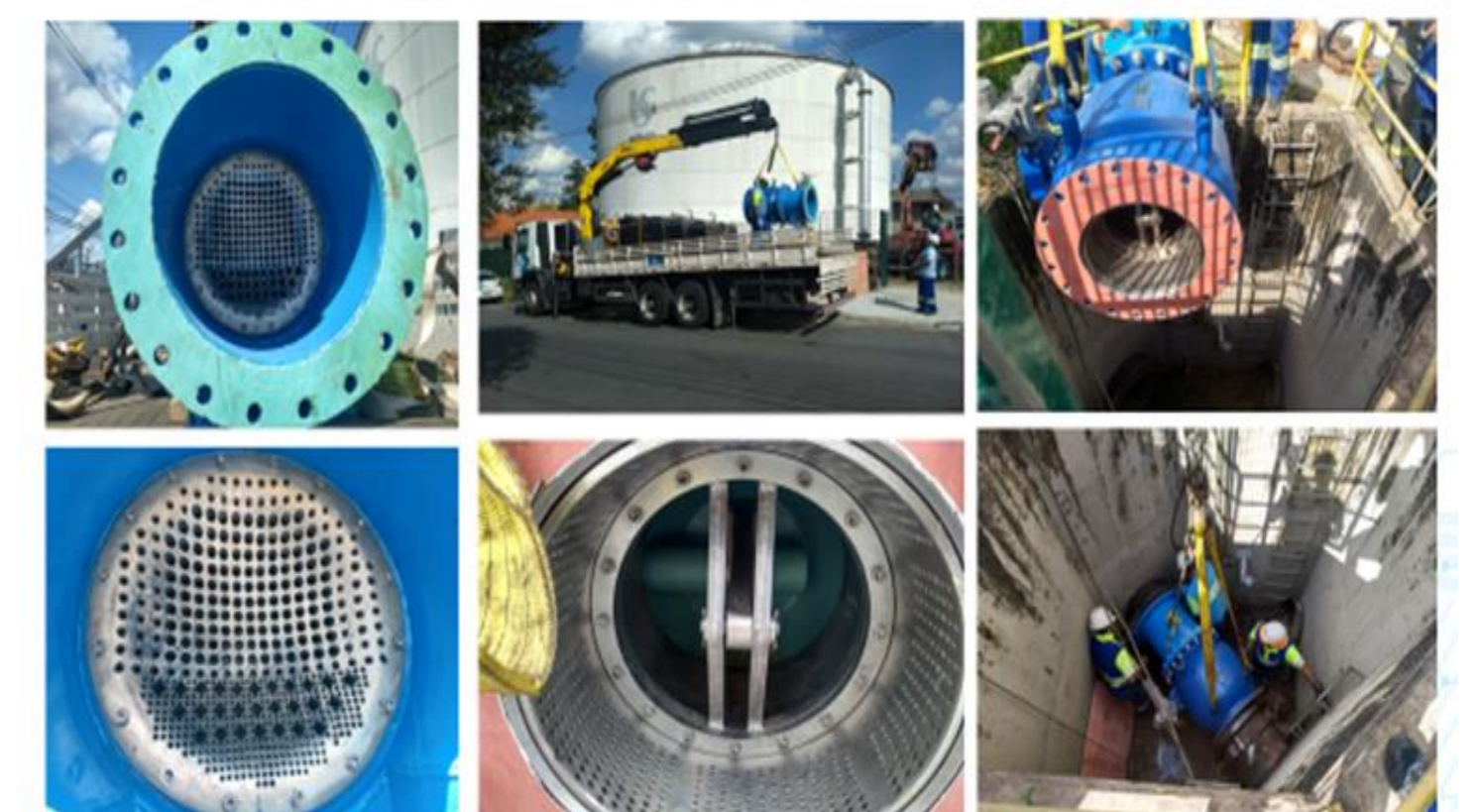
INSTALAÇÃO DO ANTEPARO DE PARTÍCULAS
