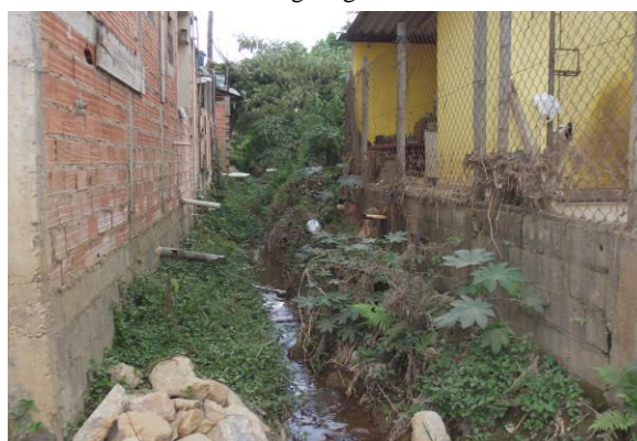
Afluente do córrego dos Grilos
