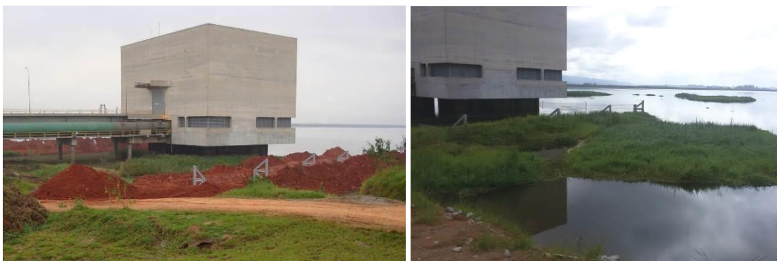
Figura 3 – Construção de barreira física.
