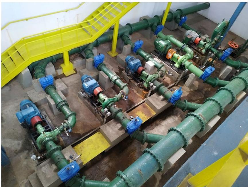
Figura 4 - Vista geral dos conjuntos motobomba da estação de bombeamento para abastecimento.
