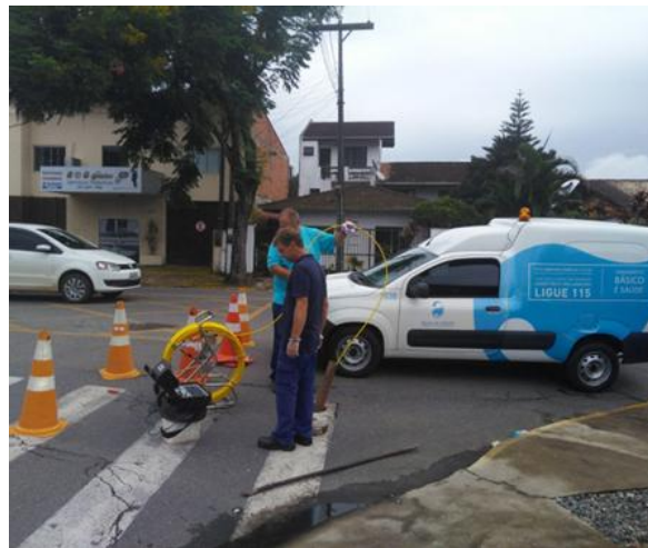
Figura 7: Execução da filmagem intratubular.
