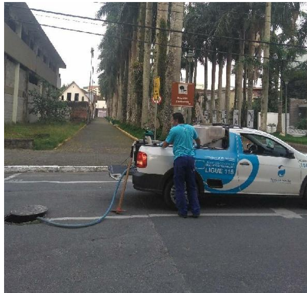
Figura 13: Aplicação do biorremediador.
