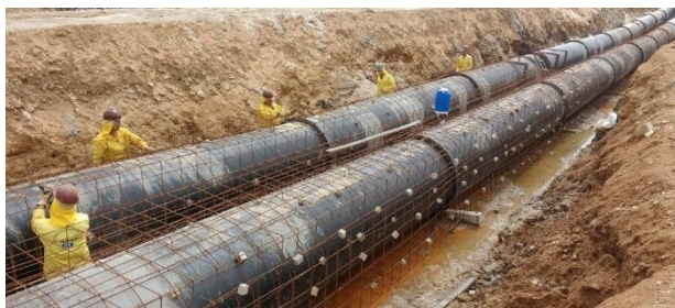
Figura 4: Construção da Adutora do Agreste (COMPESA, 2018)
