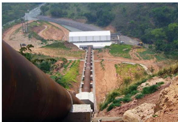
Figura 3: MCH Ponte Alta em Mato Grosso do Sul (Intertechne, 2020)
