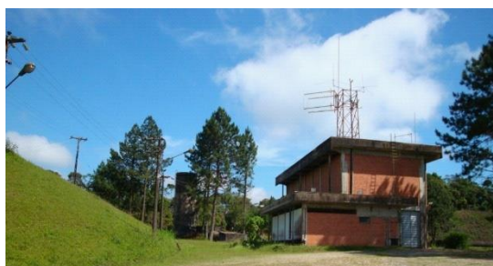
Figura 12: Vista externa da EEA Sifão 22
