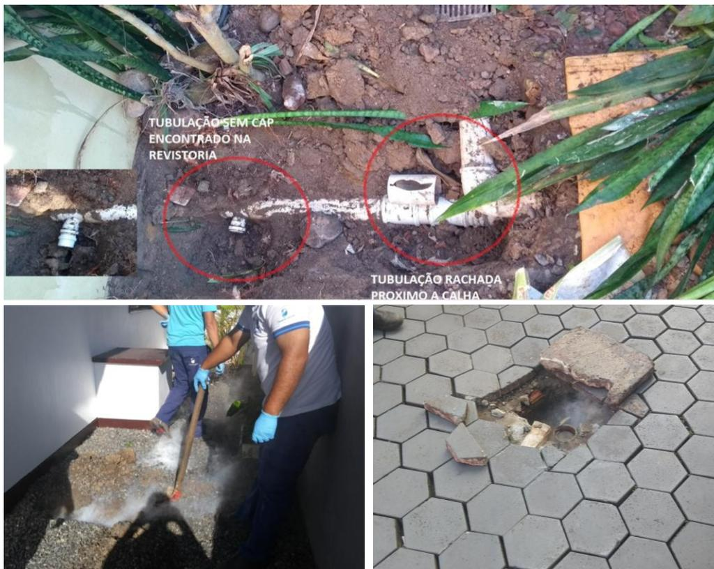
**Figura 18: Locais de afluxo direto na rede de esgoto.**
