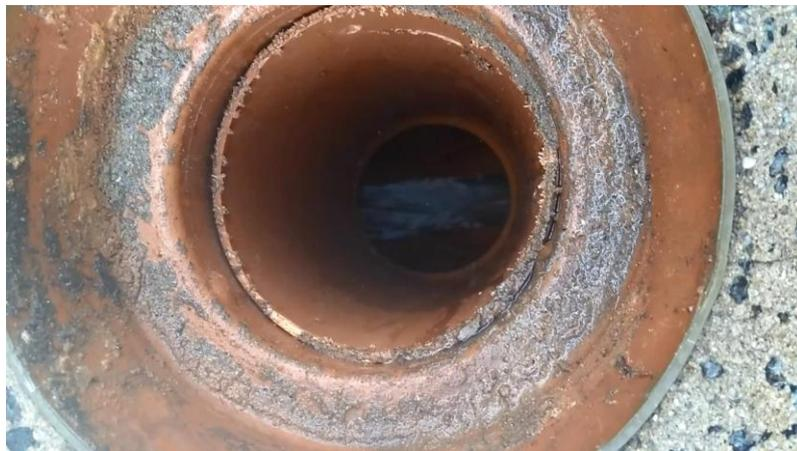
**Figura 12: CI com suspeita de contribuição pluvial.**
