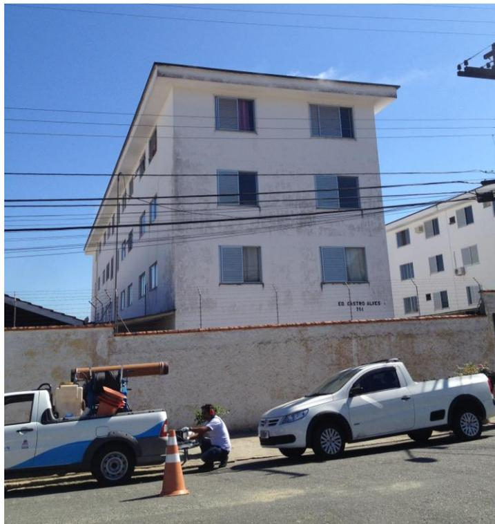
**Figura 8: Teste de fumaça no poço de visita (PV), demonstrando a saída de fumaça na calha do edifício.**
