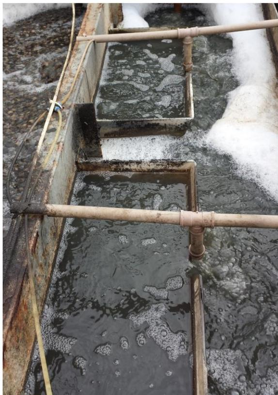
**Figura 2: Mistura rápida, com aplicação de coagulante em vertedor triagular.**
