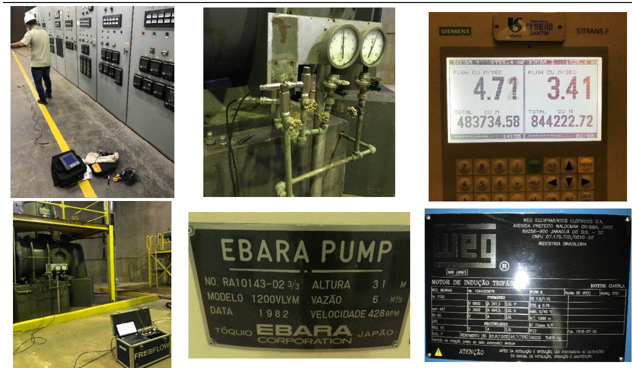
Figura 2: Fotos da instalação.
