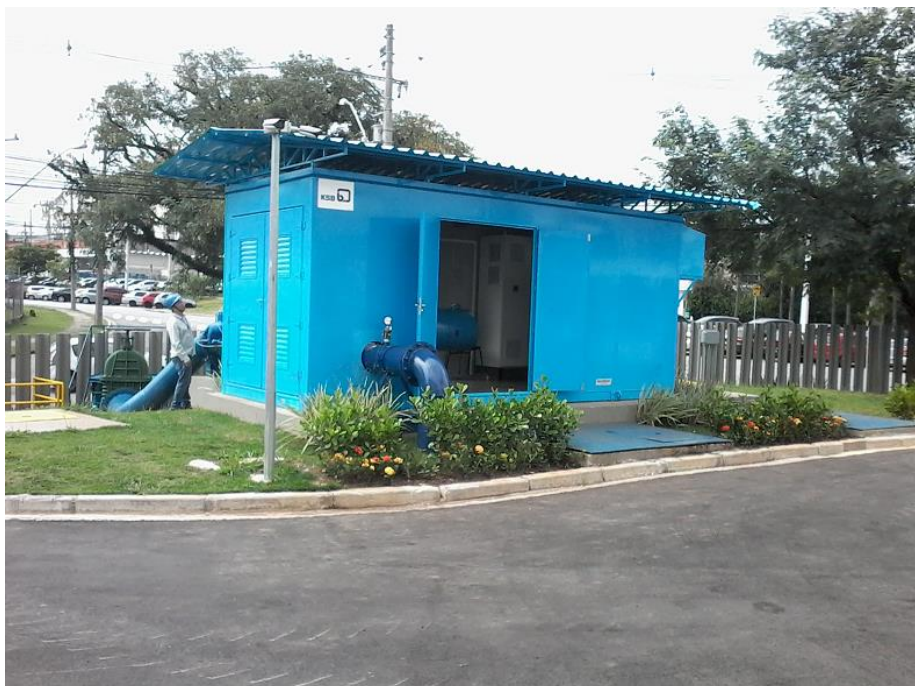
Figura 9: Vista da BFT Tamboré (vista para o logradouro) (fonte: Sabesp-2018).
