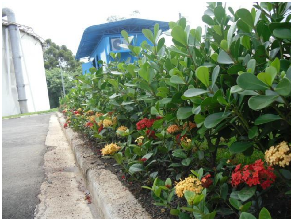
Figura 8: Vista da BFT Tamboré (entrada de reservatório (fonte: Sabesp-2018).
