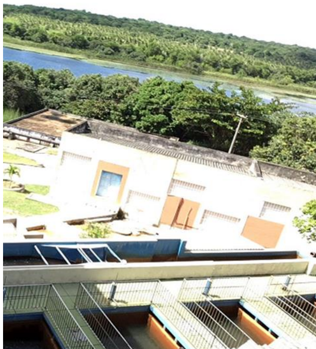
Figura 4 - ETA Lagoa do Jiqui – Filtros Fonte: Própria
