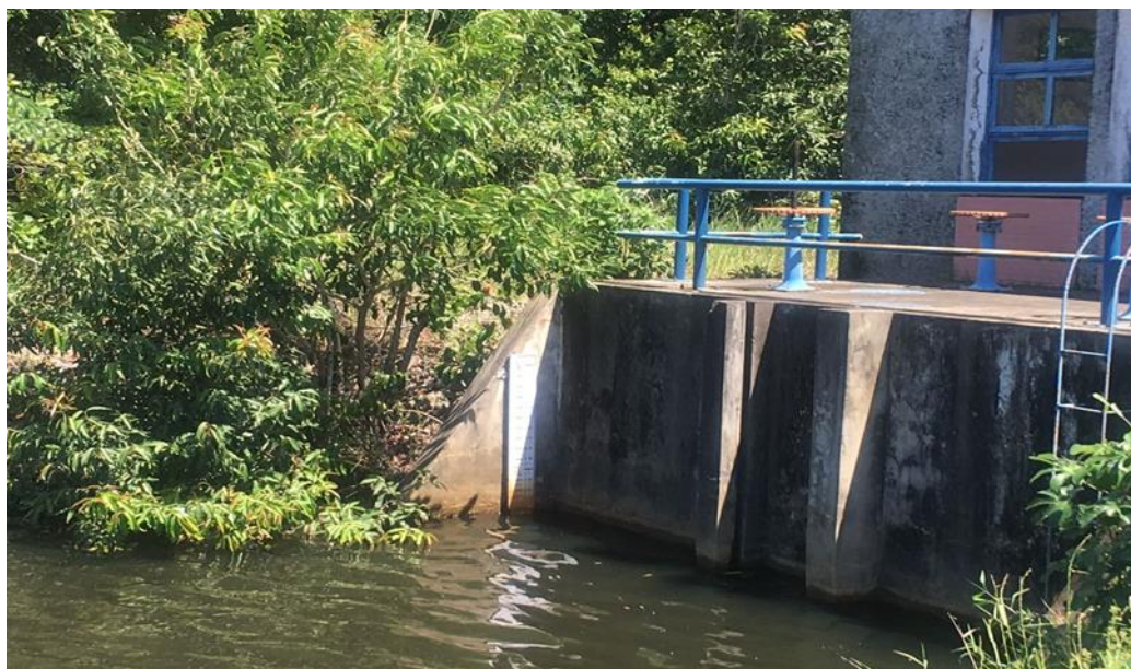
Figura 1 - ETA do Jiqui - Captação Fonte: Própria
