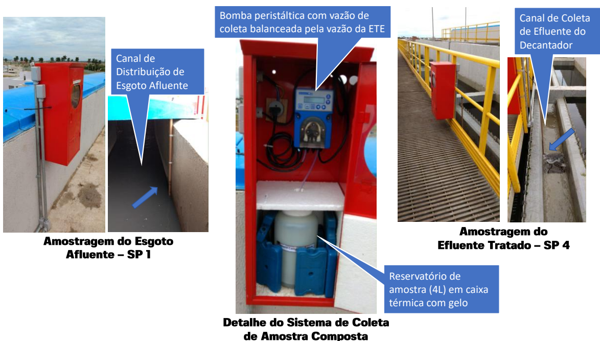
Figura 5 – Pontos de instalação e detalhe do sistema de coleta das amostras compostas.
