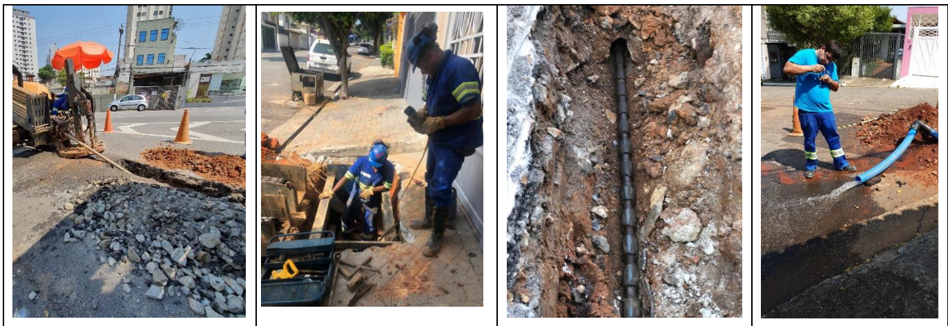
Figura 3: Substituição de rede de distribuição por método não destrutivo
