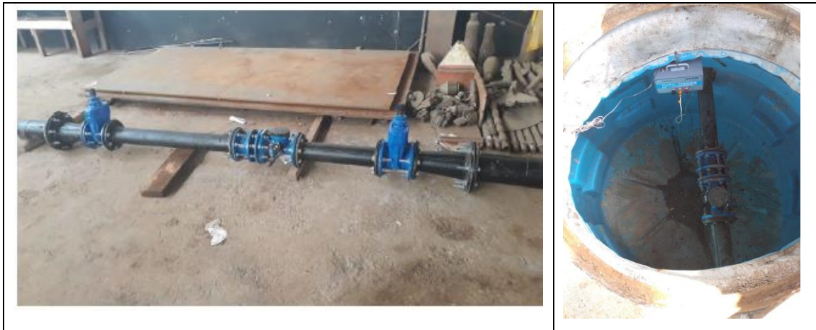
Figura 9: Implantação da DMC Moyses Kuhiman com PV retomoldado de PEAD
