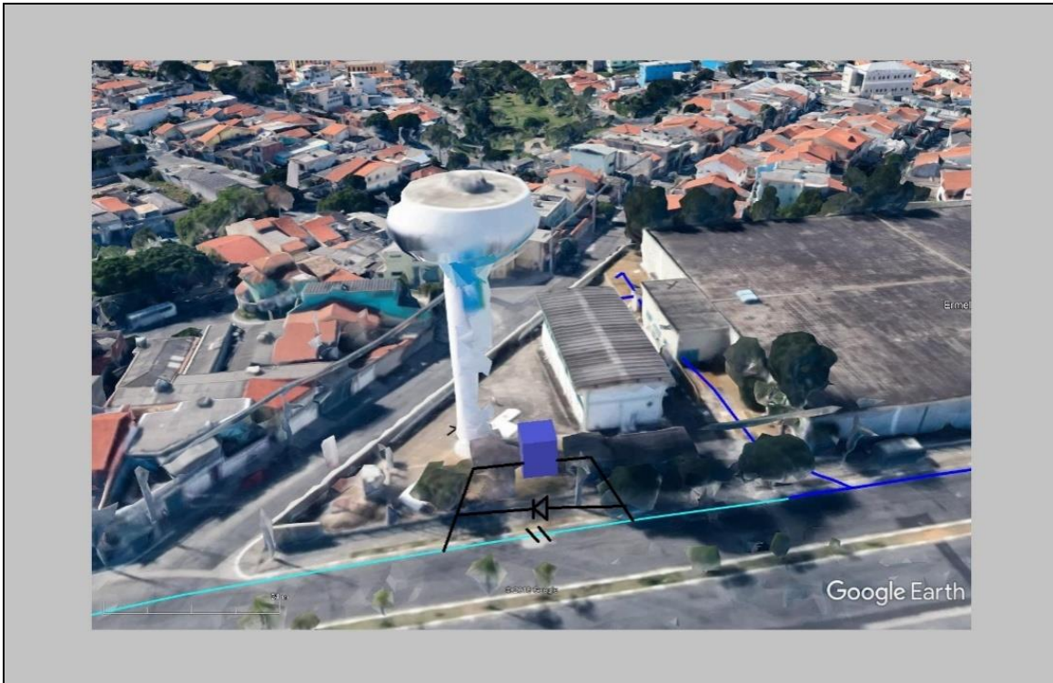
Figura 9: Localização do booster no reservatório Ermelino Matarazzo.
