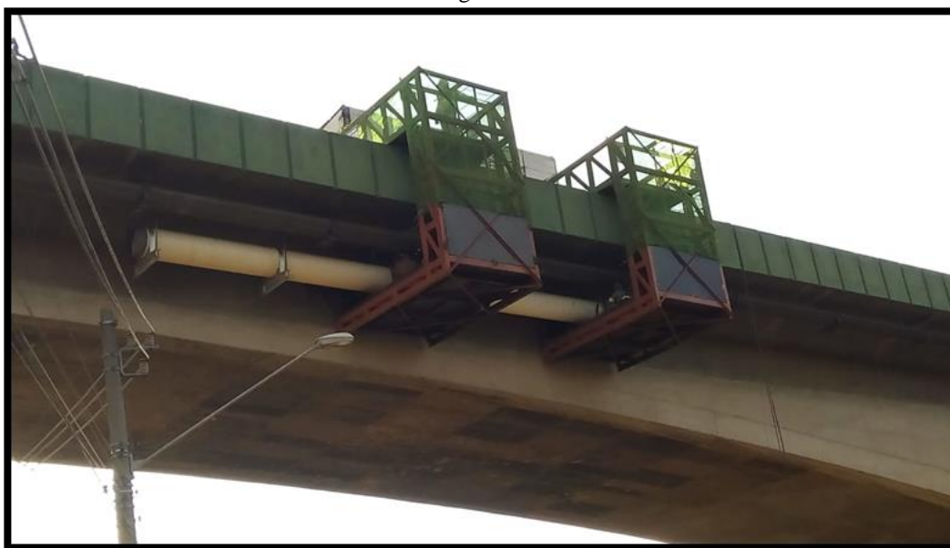
Figura 13: Foto da estrutura construída para execução da travessia.
