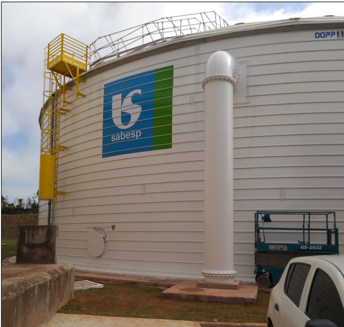
Figura 7: Foto da Ampliação do Reservatório Vila Industrial.
