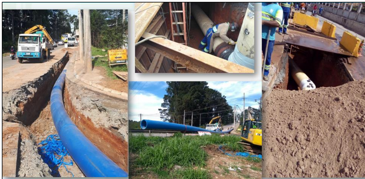
Figura 12: fotos de vários trechos da obra durante a execução.
