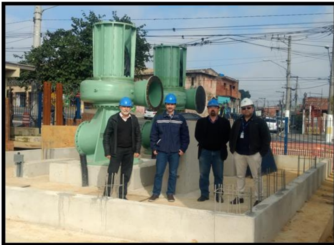
Figura 13: Foto do booster Ermelino-Guarulhos durante a execução.
