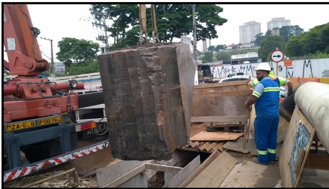
Figura 14: Foto da retirada do bloco de rocha.
