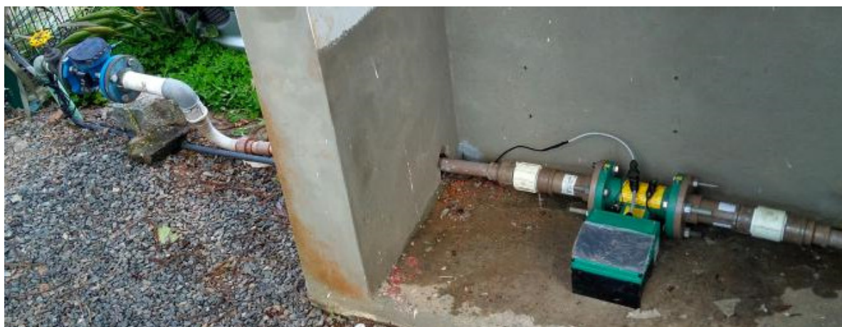
Figura 2: Hidrômetro ultrassônico na cor azul (à esquerda) e hidrômetro eletromagnético na cor verde (à direita).
