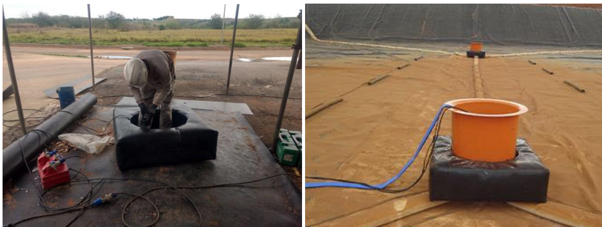
Figura 7 – Cesto para captação da água da chuva
