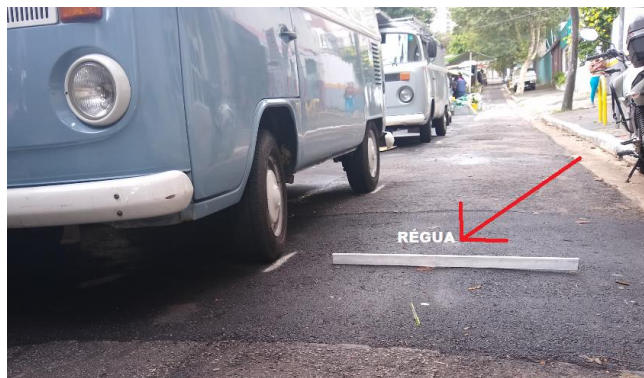
Figura 3: Utilização da régua para verificar nivelamento da vala.
