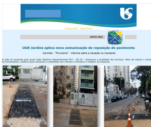
Figura 1: Exemplos de aplicação do carimbo nas valas
