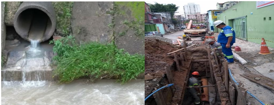
Figuras 9– Obra de despoluição de Córregos (Ipiranga)
