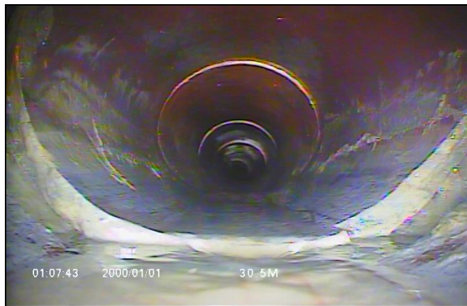
Figura 5 – Televisamento e Vídeo inspeção de rede de esgoto
