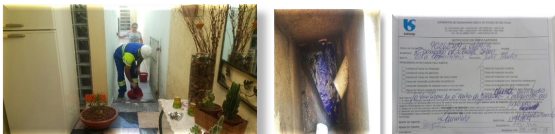
Figura 7– Fotos de vistoria de águas pluviais e notificação para regularização
