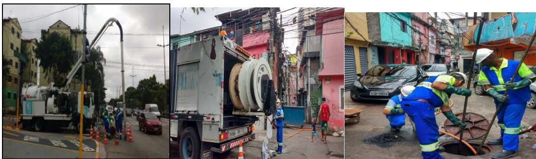
Figuras 11 – Limpeza de rede Coletora
