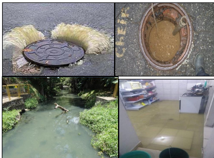
Figuras 2 – Obstruções, poluição e refluxo
