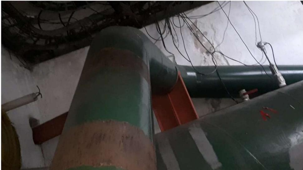
Fig. 2 – Local de instalação do medidor ultrassônico. O escoamento vem de diversas singularidades a montante, mostradas na figuras posteriores
