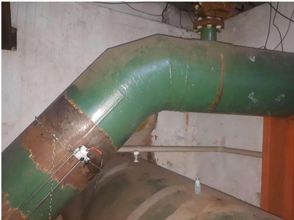
Fig. 3 – Medidor ultrassônico instalado.
