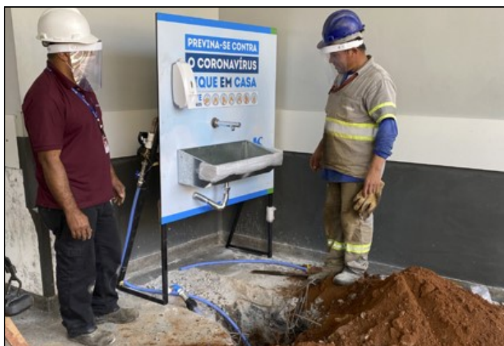
Figura 1: Instalação de lavatório de mãos no bairro São Miguel Paulista – São Paulo
