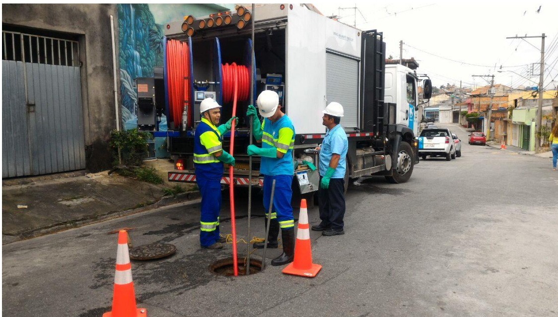
Figura 4 – Equipe de campo utilizando o Sewer Jet.
