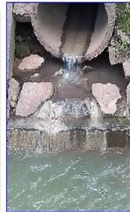
Depois da obra
