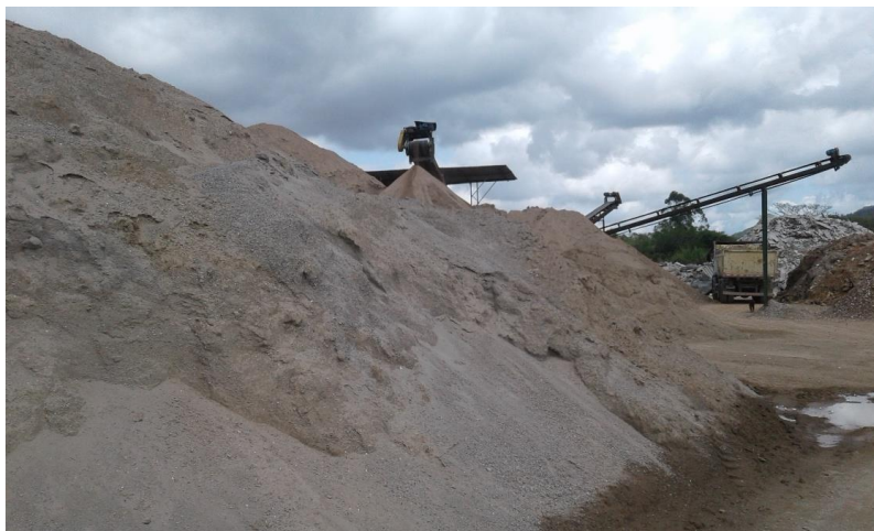
Figura1: Detalhe do processo produtivo na usina de reciclagem de resíduos de construção civil 3R'S Reciclagem em Criciúma, SC, Brasil
