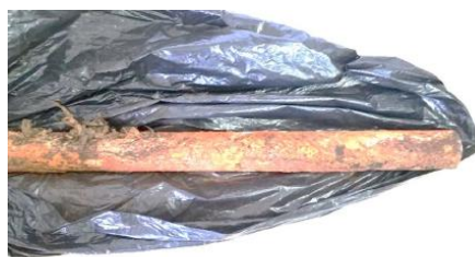
Figura 11: Tubulação deteriorada removida
