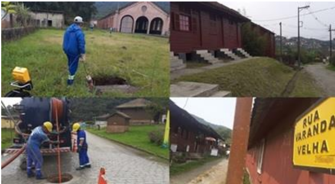
Figura 2 - Equipes mapeando lançamentos irregulares nas nascentes.
