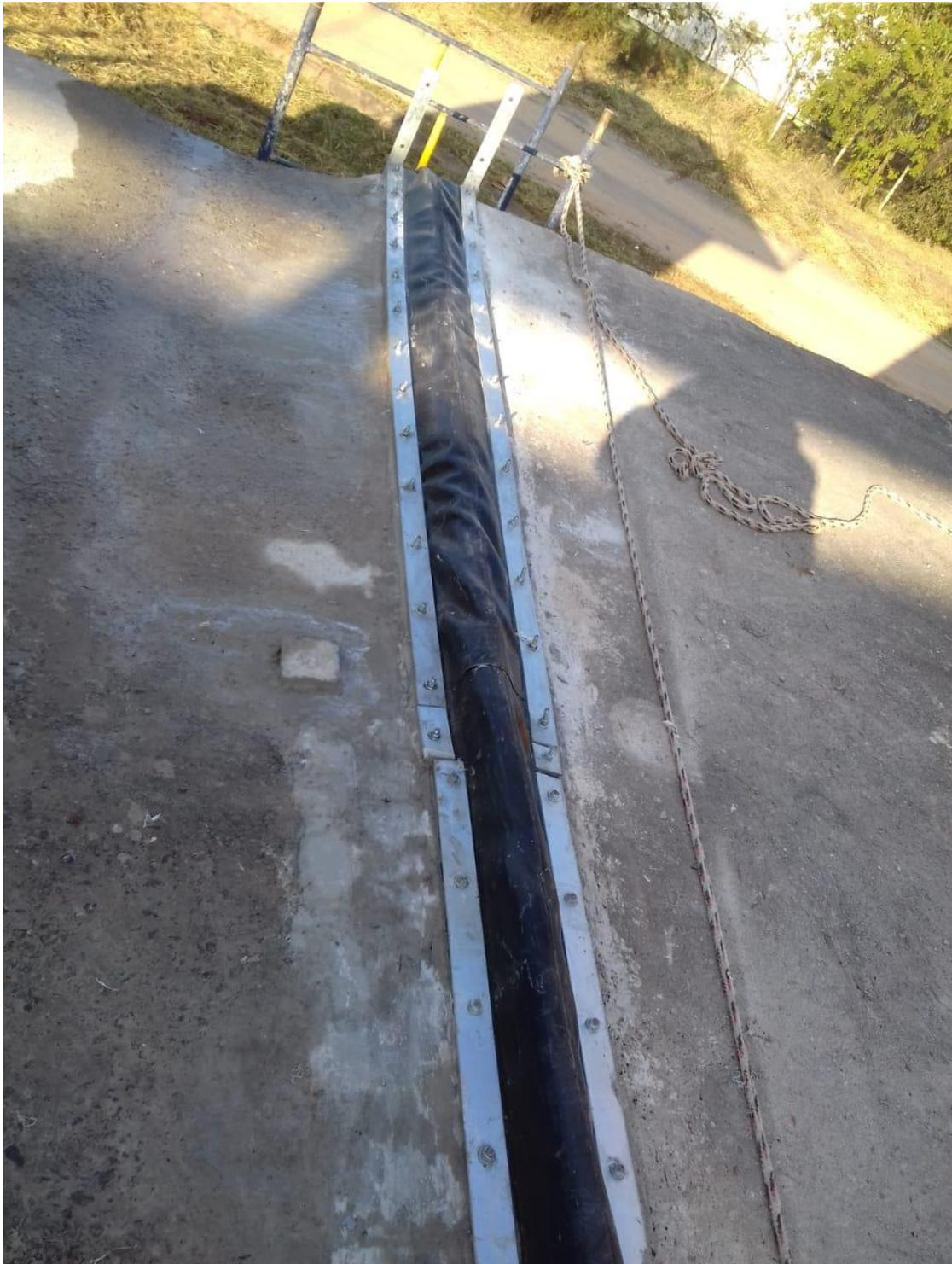
Imagem 7 – Após a implantação da Junta tipo Ômega
