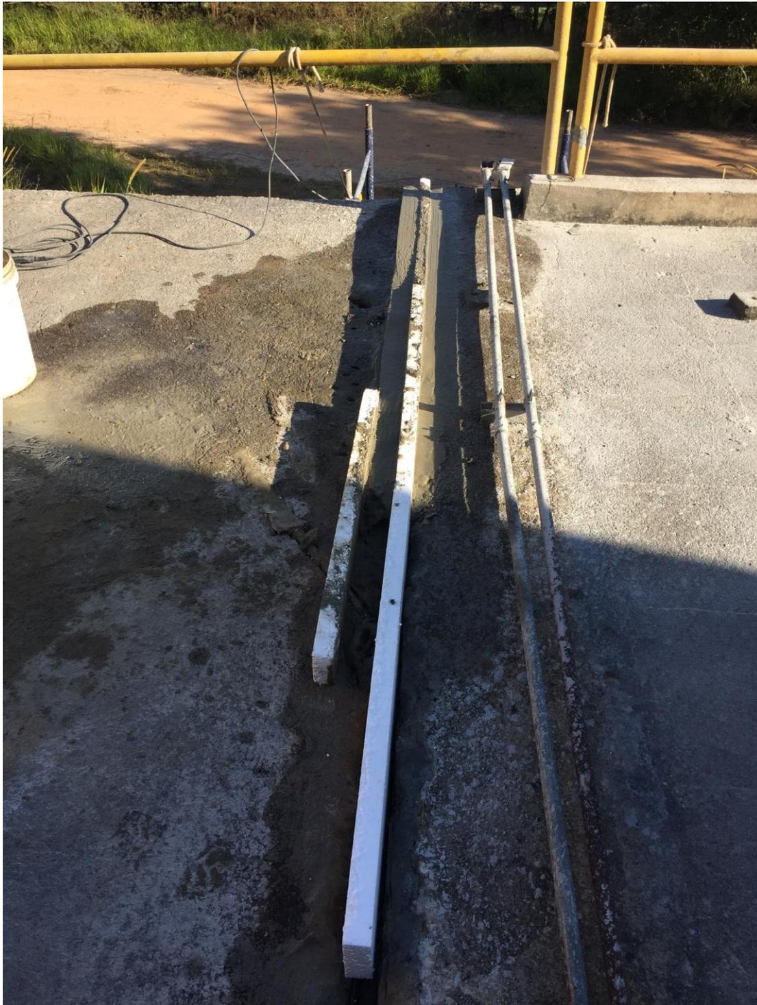
Imagem 3 – Nivelamento do local a ser instalado a junta elastomérica
