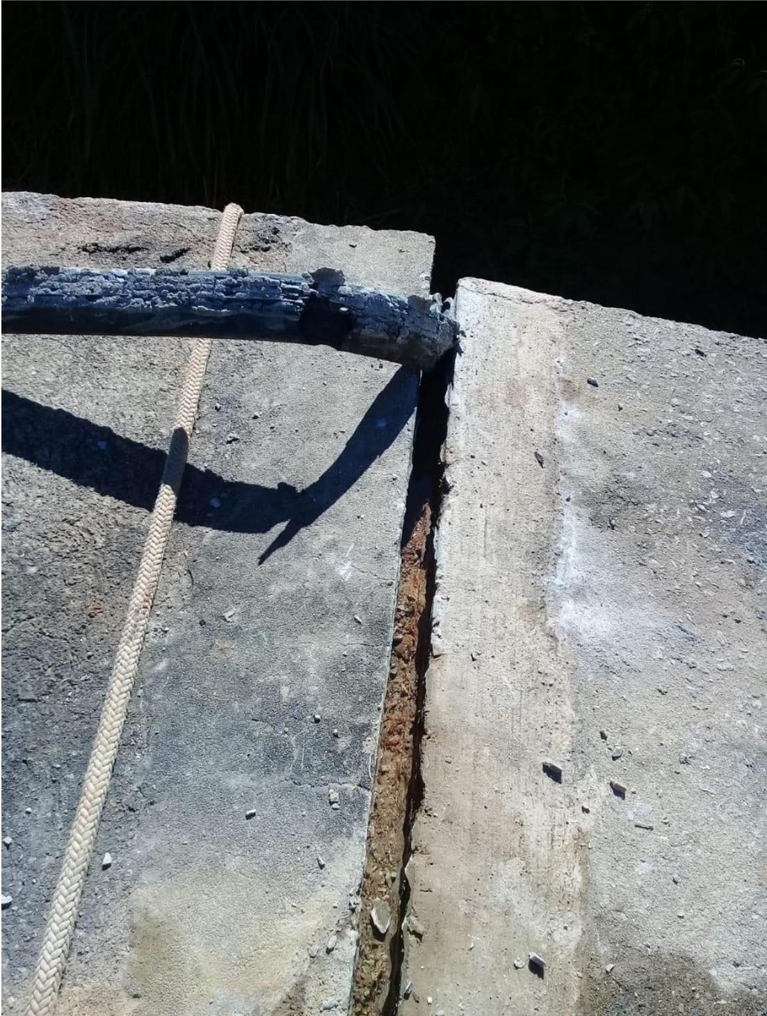
Imagem 2 – Remoção da Junta Elastomérica danificada
