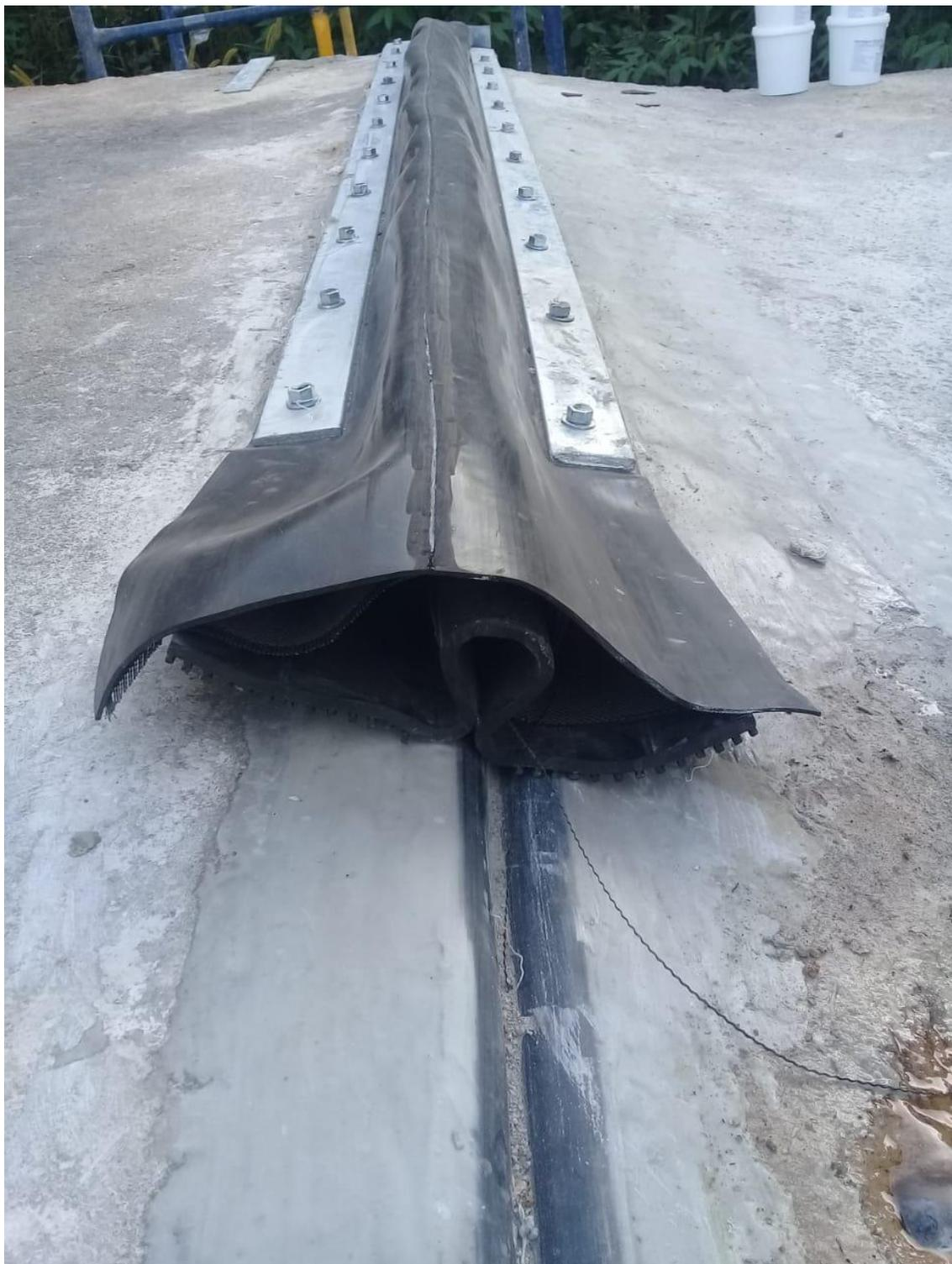
Imagem 5 – Instalação da Junta tipo Ômega com a manta de borracha
