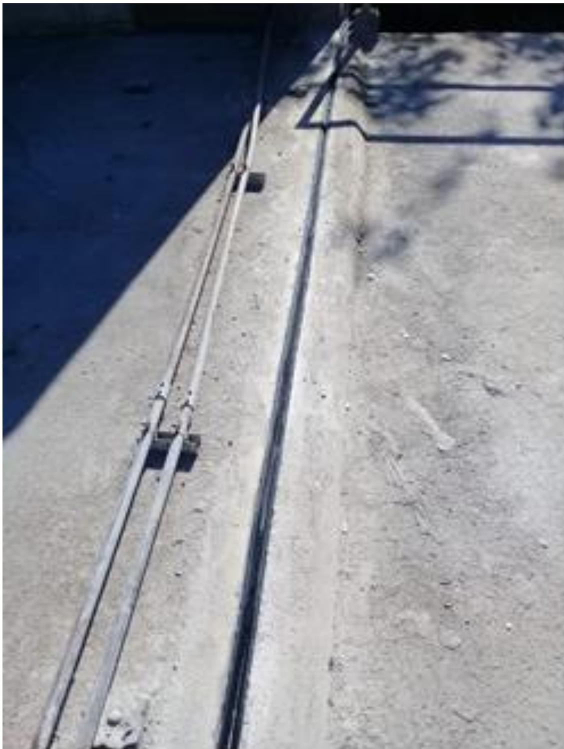
Imagem 4 – Instalação da pré junta Elastomérica
