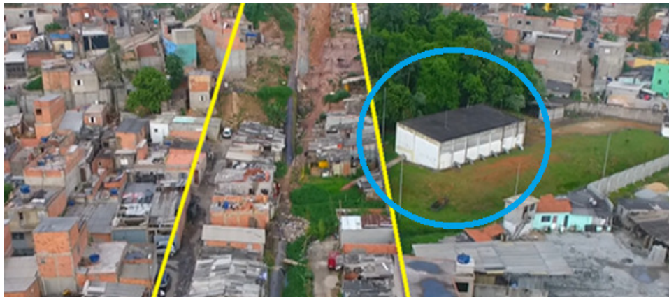
Figura 22: Estação elevatória de água (EEA) da SABESP circulado em azul
