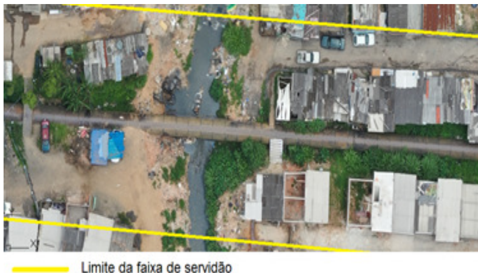
Figura 14: Moradias instaladas na FS da adutora de água
