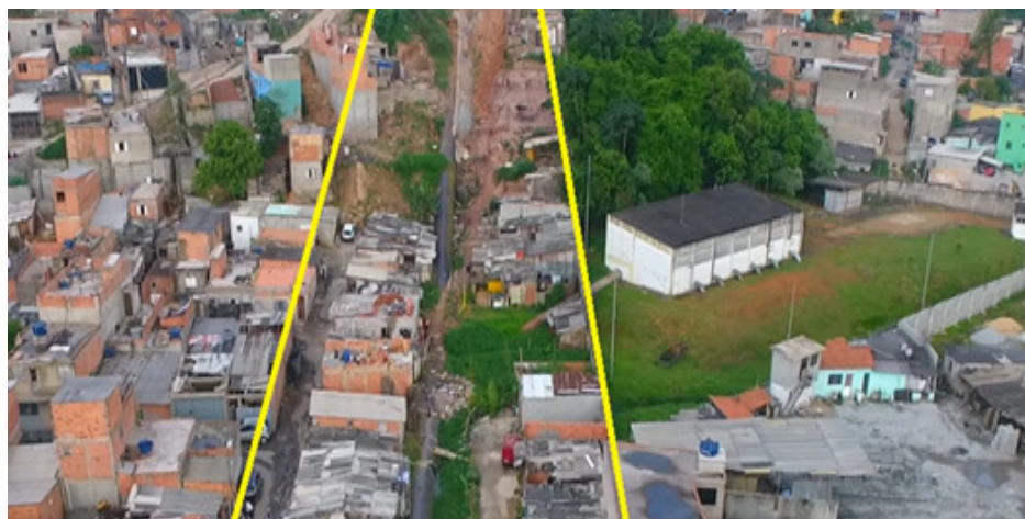
Figura 15: Moradias instaladas dentro da Faixa de Segurança
