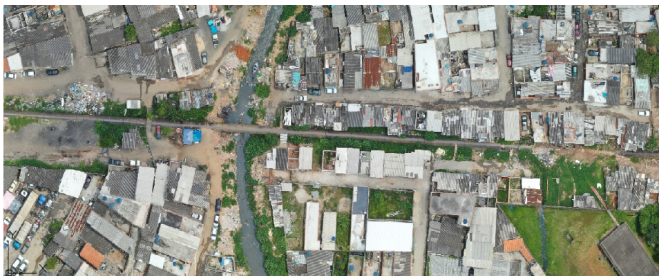
Figura 20: Aproximação no ortomosaico sobre a área da adutora
