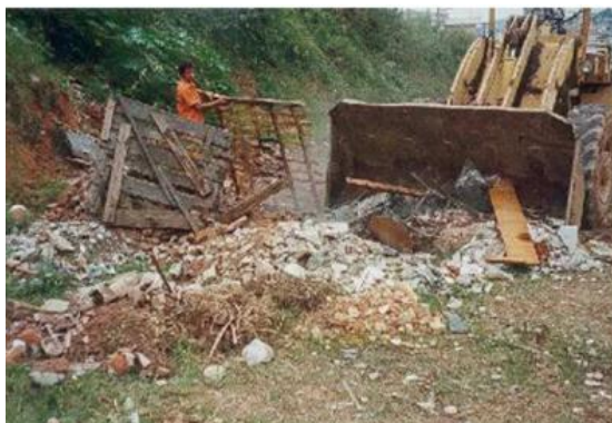
Figura 2: Remoção de entulho com maquinário pesado (CARNEIRO et al , 2001)
