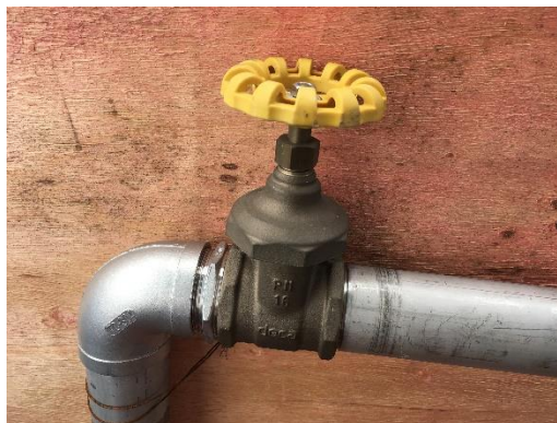
Figura 2: Detalhe da identificação do aço inoxidável AISI 304 – Conjunto CDHU.
