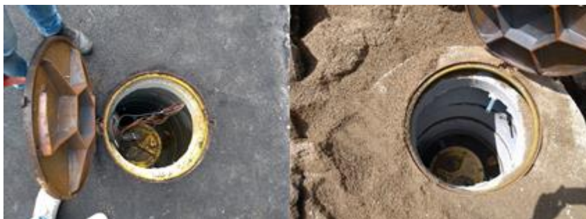
Figura 14: Estação Elevatória de Esgoto Compacta após instalação no estacionamento do cliente Sonda – Unidade Jaçanã.
