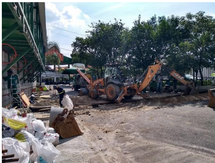
Figura 15: Obra de instalação da Estação Elevatória de Esgoto Compacta
