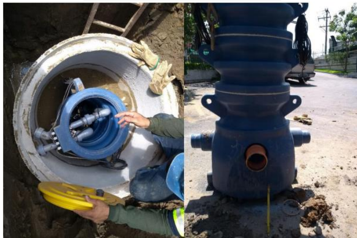
Figura 13: Estação Elevatória de Esgoto Compacta utilizada para instalação no estacionamento do cliente Sonda – Unidade Jaçanã.
