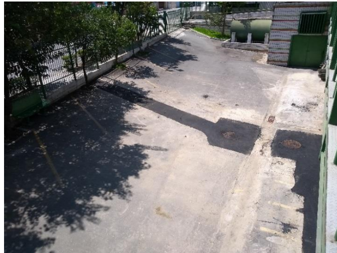
Figura 16: Foto da obra concluída após instalação da Estação Elevatória de Esgoto Compacta
