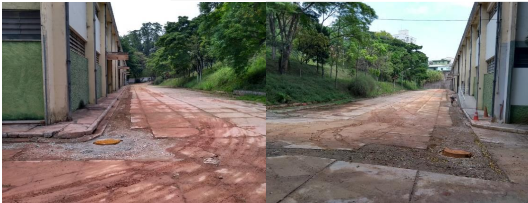
Figuras 5 e 6: Implantação da rede de esgoto no pátio interno do Complexo Barro Branco prédio 3
