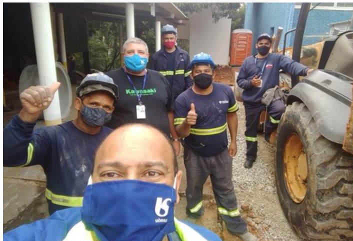
Figura 11: Equipe de implantação da rede de esgoto em ação
