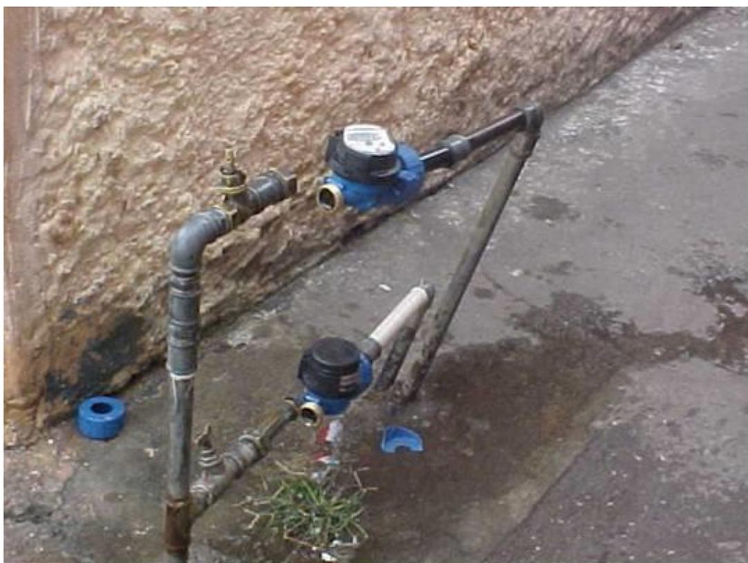
**Foto 04 – Ligação de água desconectada durante o teste**
