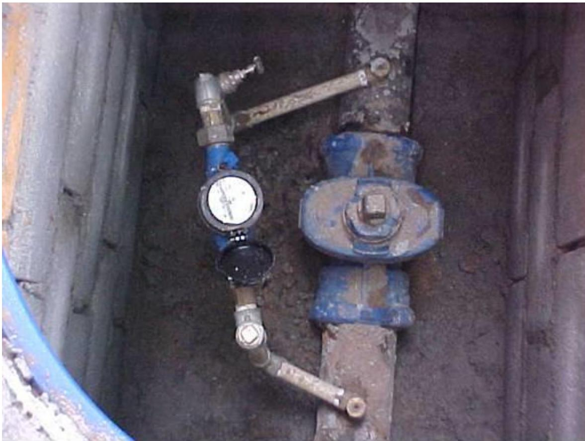
**Foto 02 – Detalhe do By – Pass e medidor instalado**
