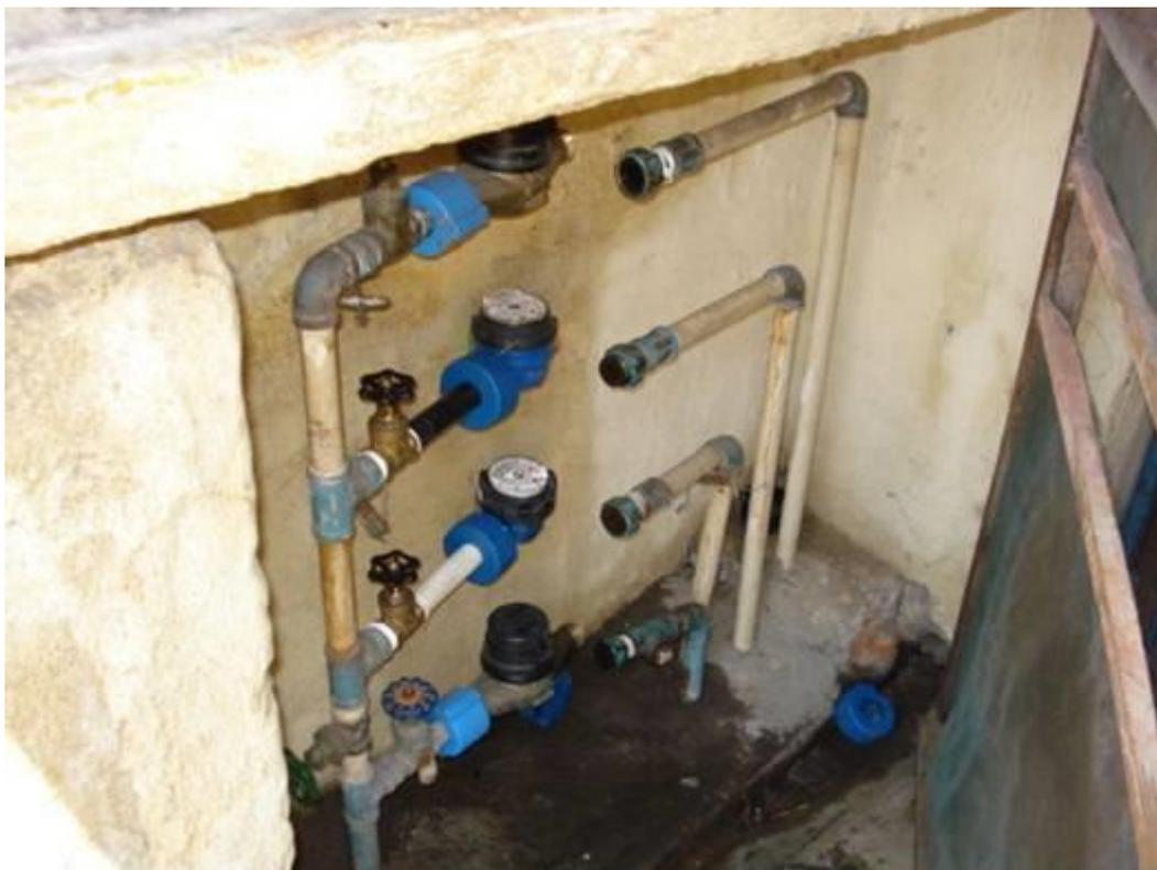
**Foto 03 – Ligação de água desconectada durante o teste**
