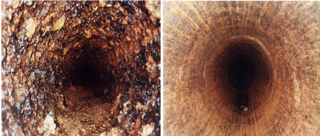
Figura 10 – Estado da Tubulação antes e após a passagem de Pigs (Fonte: Hidropig)
