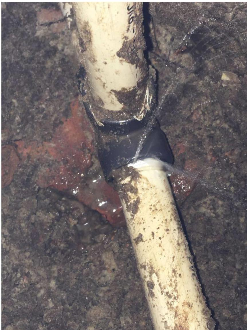
**Figura 01 – Exemplo de Vazamento Interno (Fonte: do Autor)**
