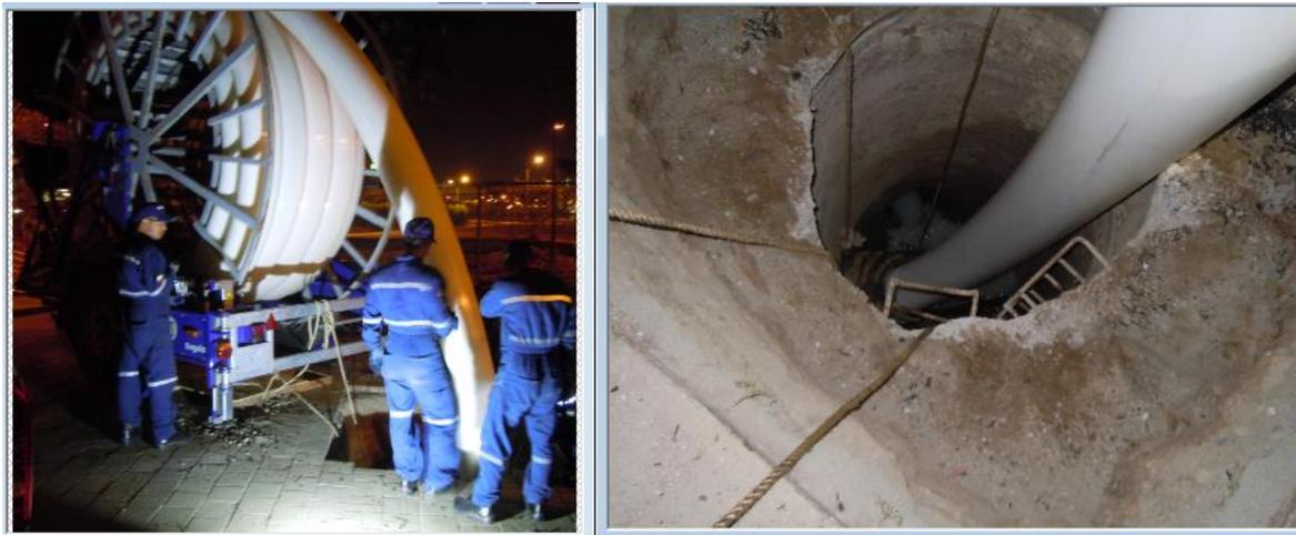
**Figura 6: Inserção Compact Pipe – Fonte: Acervo Wavin Colômbia**
