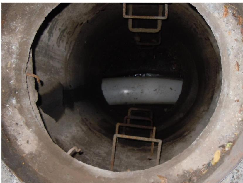
**Figura 7: Visão da tubulação em PV intermediário – Fonte: Acervo Wavin Colômbia**
