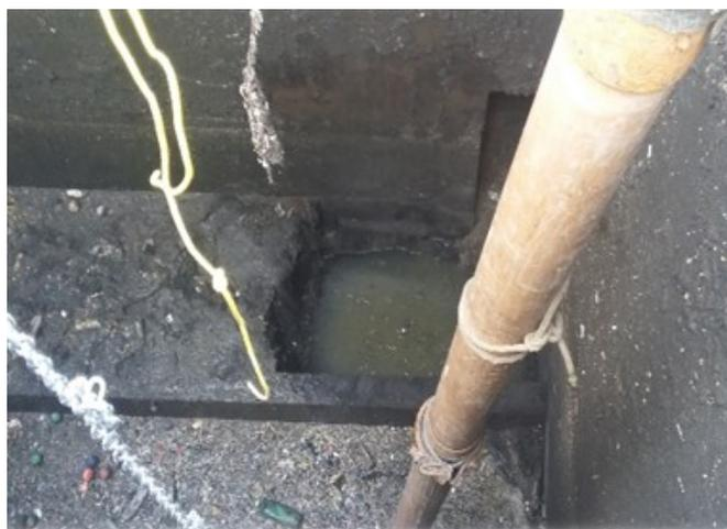
**Figura 2: Sobrenadantes acumulados no poço de sucção**
