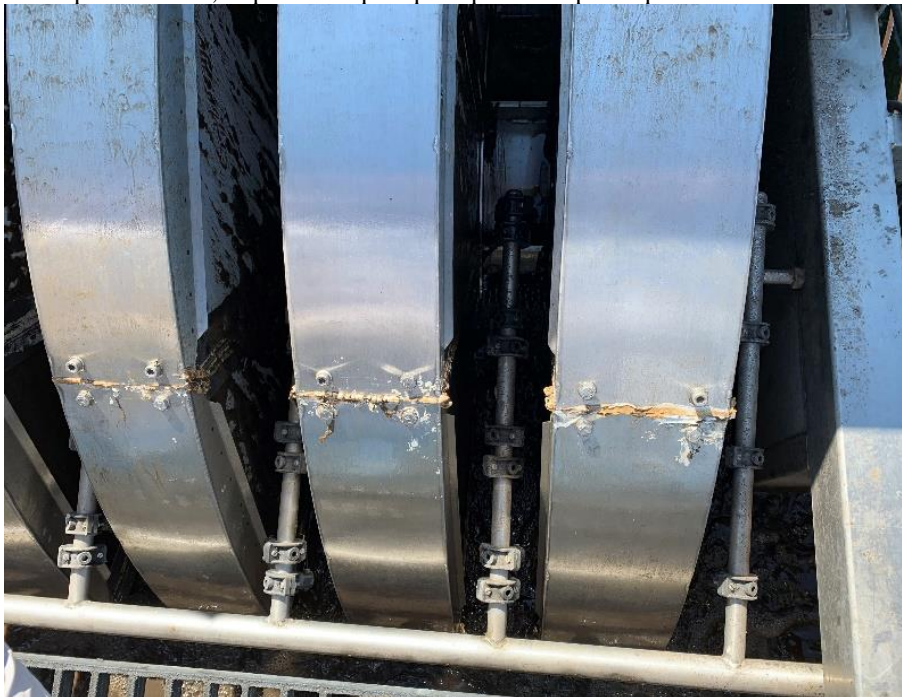
Figura 12: Registro do Filtro RDD em funcionamento
