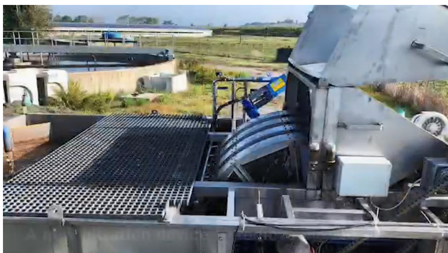
Figura 1: Instalação do Equipamento Piloto na ETE existente
