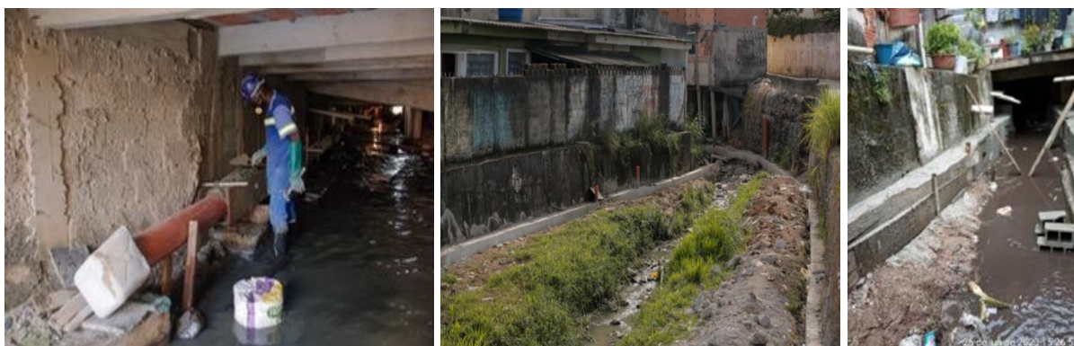
Figura 8: Exemplo de execução de solução alternativa, com assentamento de rede coletora de esgoto nas margens dos córregos.
