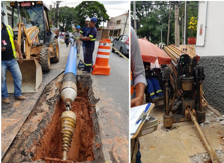
Figura 2: Visitas de campo para o acompanhamento da instalação de adutora e rede de água por HDD.
