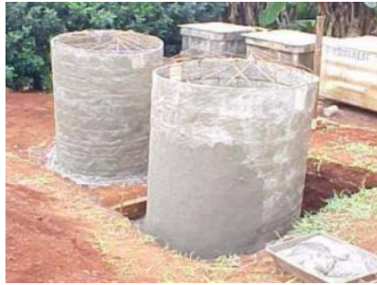
Figura 2: Vista do RAC em construção.
