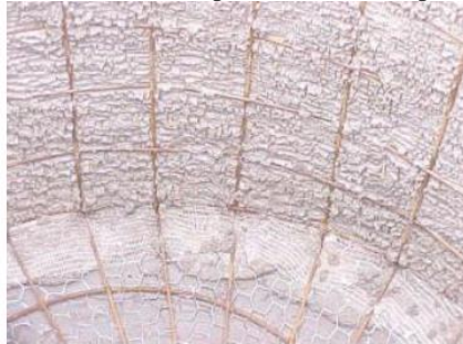
Figura 3: Vista interna do conjunto RAC construído.
