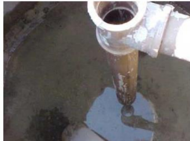
Figura 4: Detalhe do sistema de entrada interno.
