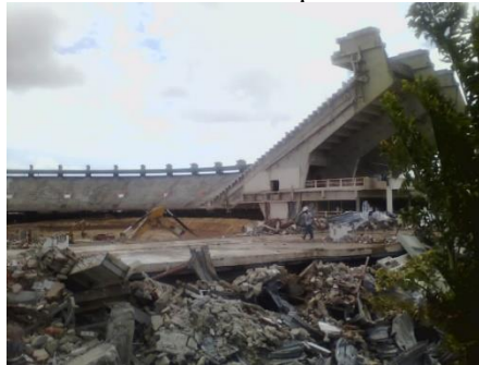
Figura 1. Local onde foi demolida a arquibancada da Arena Castelão.
