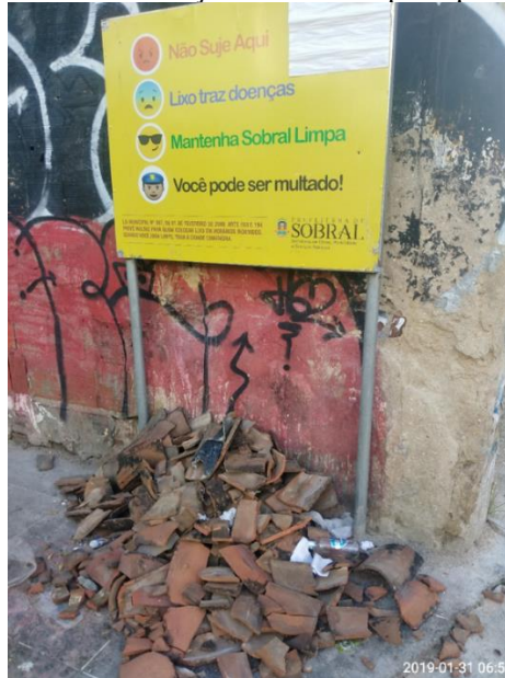
Figura 3. Resíduos de construção em uma das principais ruas da cidade de Sobral.
